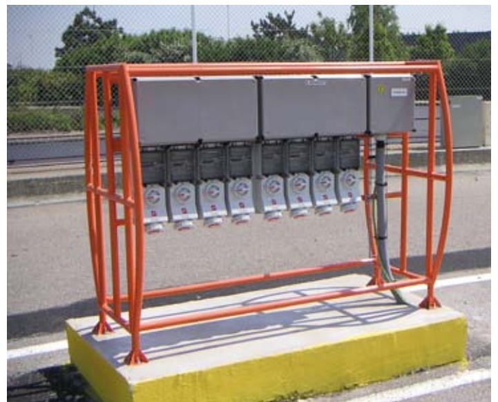
Container Terminal, Le Havre – Pháp
